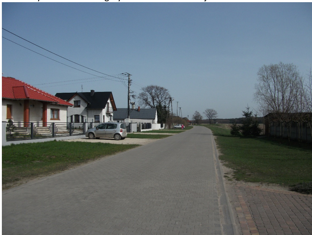
Ryc. 13. Linia energetyczna SN 15 kV w miejscowości Tworzanki
