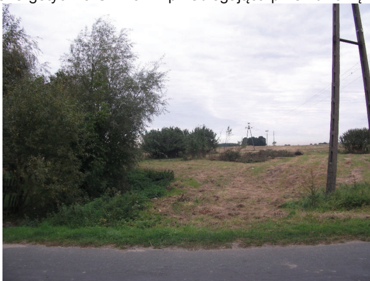
Ryc. 21. Linia energetyczna SN 15 kV przebiegająca przez działkę o nr ewid. 236/3
