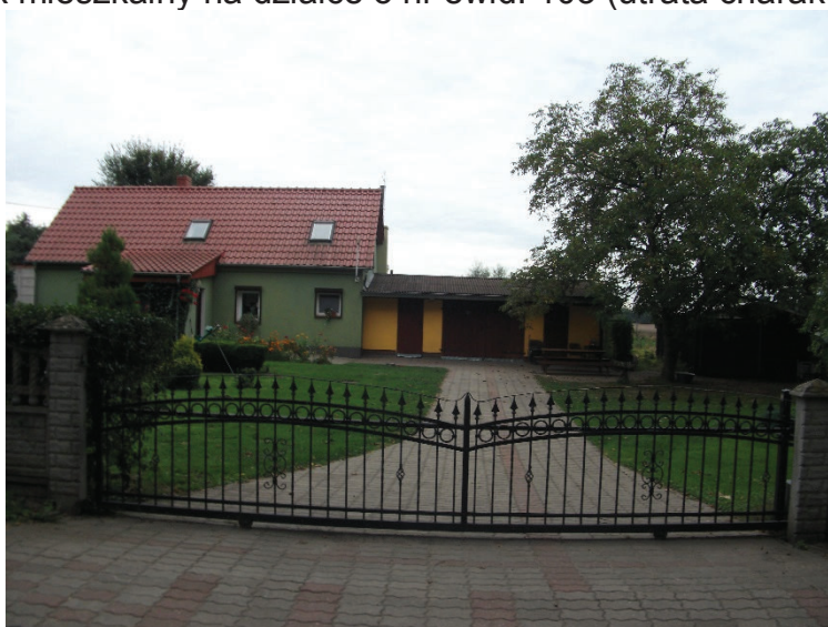
Ryc. 32. Budynek mieszkalny na działce o nr ewid. 103 (utrata charakteru zabytkowego)
