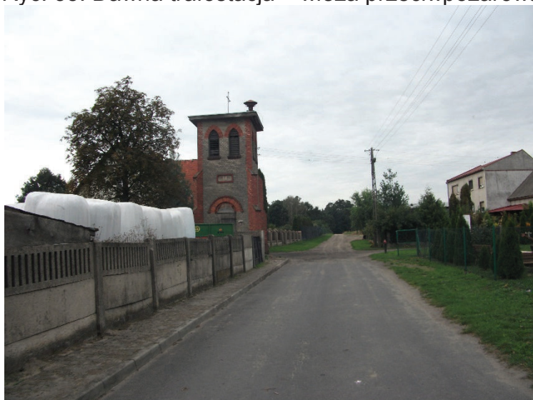
Ryc. 35. Dawna trafostacja – wieża przeciwpożarowa
